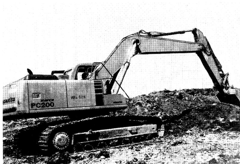
Рис. 3.11. Разработка траншеи одноковшовым экскаватором
