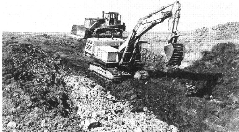
Рис. 3.14. Планировка трассы и разработка траншеи для вновь прокладываемого участка нефтепровода в совмещенную траншею
